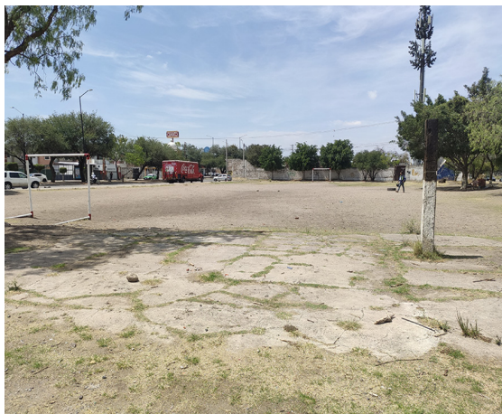
Figura 3. Parque Hilario Medina, a la izquierda (CAMPOS DEPORTIVOS CON MÍNIMA INTERVENCIÓN CONSTRUCTIVA), y Minideportiva IV Centenario, a la derecha (DEPORTIVOS VECINALES CONSTRUIDOS)
