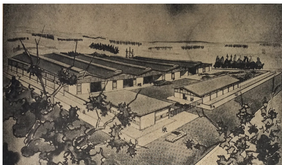
Figuras 1 y 2. Perspectiva y proceso constructivo del proyecto para la fábrica y talleres Crup en la ciudad industrial de ACOPI, 1958
