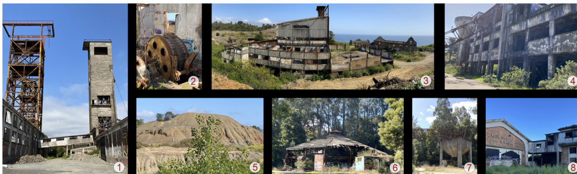
Figura 3. Fotografías de la infraestructura industrial presente en el territorio
