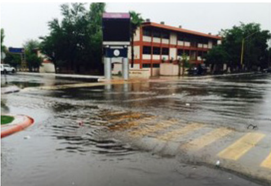
Figura 4. Escurrimiento de agua en el campus por la lluvia del 7 sept. 2016
